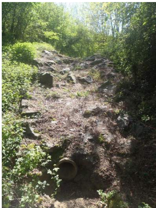
Le déversoir et l'ouvrage de restitution (parement aval)
