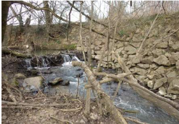
Figure 18 : Seuil du Cabanon composé d'un déversoir (à l'amont) et d'un seuil en enrochement (à l'aval)
