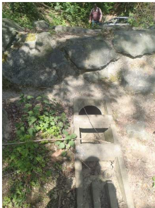
L'ouvrage de transmission du débit au réseau en aval (canalisation + déversoir)
