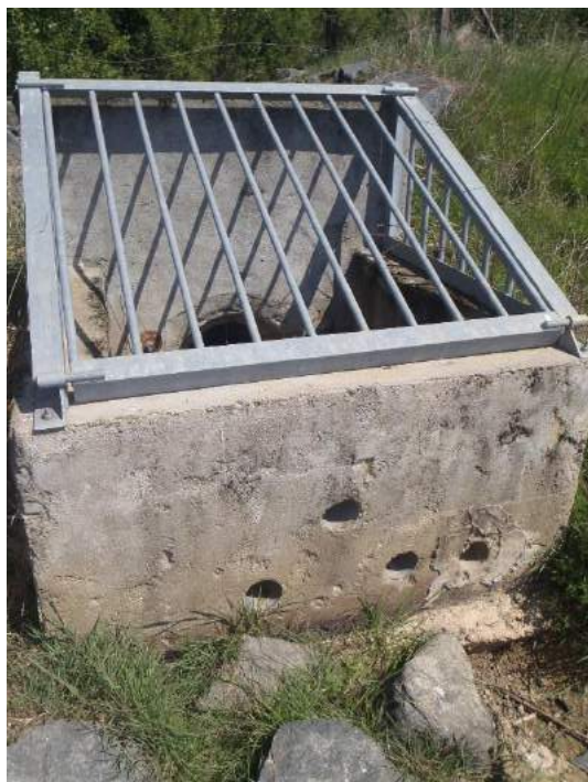
L'ouvrage de régulation
