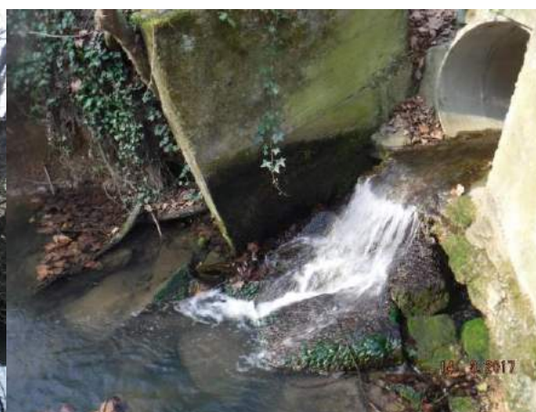
Figure 32 : Seuil de Grelonges (Ruisseau des Combes)
