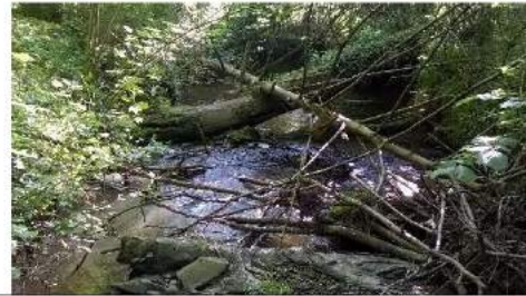
La Mâtre à la Fève, Seuil rondin-bâche contourné au premier plan
