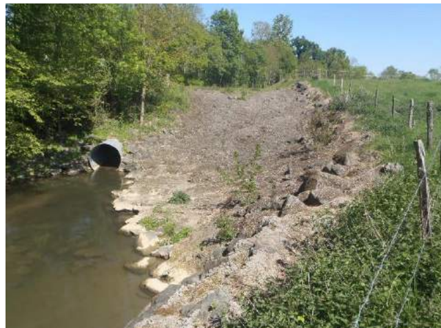
Le déversoir et l'ouvrage de restitution
