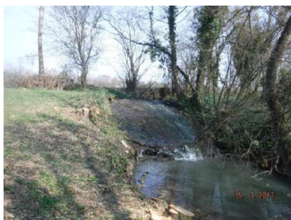
Figure 23 : Seuil du Moulin
