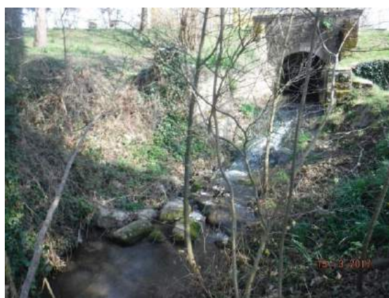
Figure 24 : Seuil du château d'Amareins
