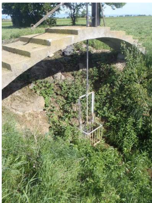
L'ouvrage de régulation
