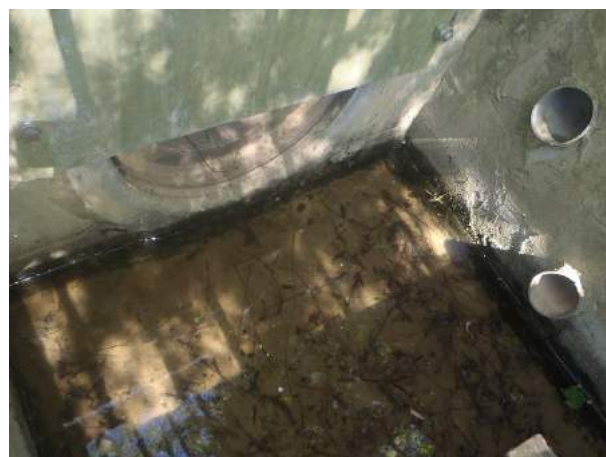
L'ouvrage de régulation
