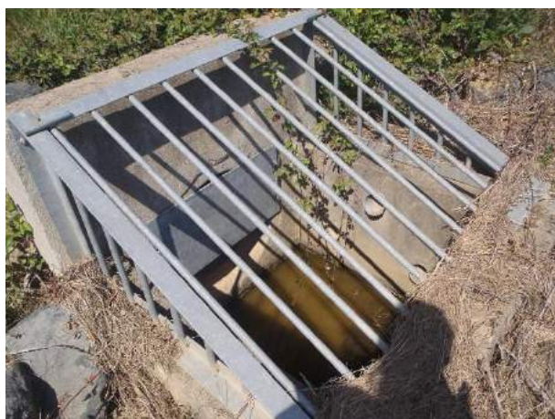
L'ouvrage de régulation
