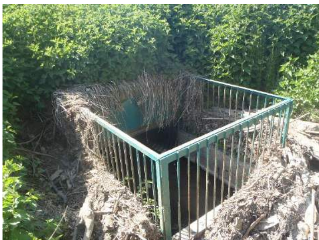
L'ouvrage de régulation
